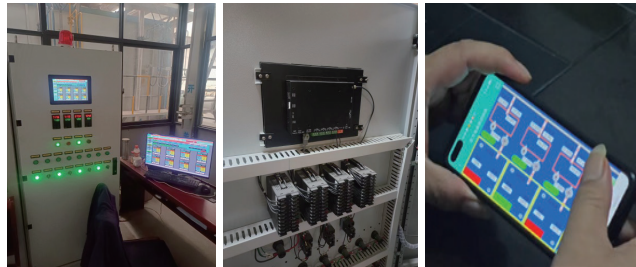
▲ 图 2-2 烘房、窑炉运行在线监测以及设备运行数据的采集分析统计
