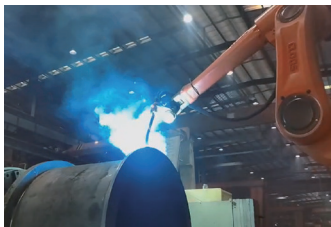
▲ 图 2-4 机器人焊接现场
