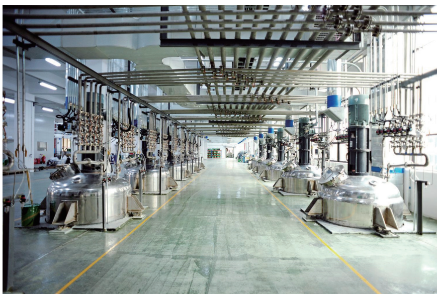
▲图 2-1 松井集团智能化生产车间
